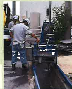
側溝の痛んだ部分だけ取り除き使える部分は利用する
